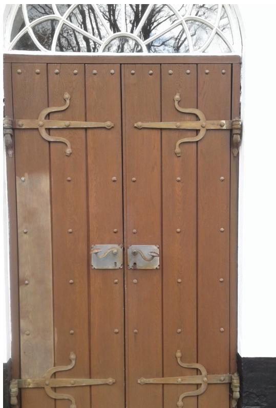
Døren i Herringe før. Yderst til venstre er den gamle plastikmaling slebet af. Foto: Jørgen Havelund.
